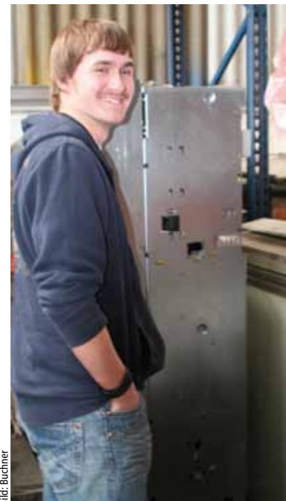
Wechselrichter bei Kranmotoren – aufgenommen in der Kranwerkstatt im Niehler Hafen mit dem Auszubildenden Maximilian-Alexander Zart.
